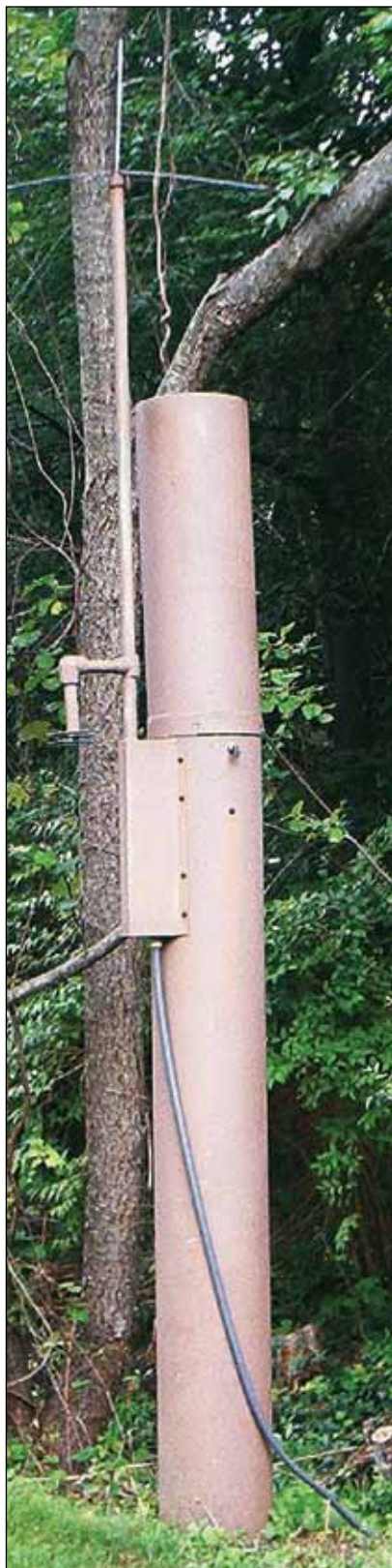
洪水警告のための河川水位モニタリングの様子。
