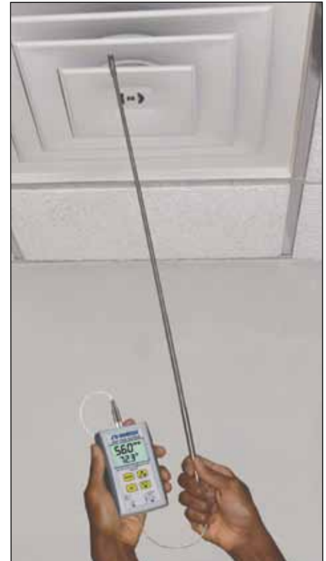
空調ダクトからの空気流量を測定
